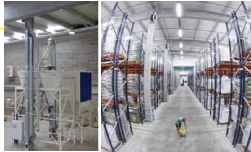
Nueva mezcladora de semillas cespitosas. Almacén para producto refrigerado.
